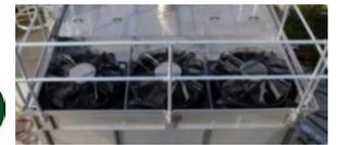
Couplés directement à leur ventilateur hélicoïde à faible vitesse de rotation et à bas niveau sonore, l'ensemble procure un **rendement énergétique et une acoustique optimisée**.
